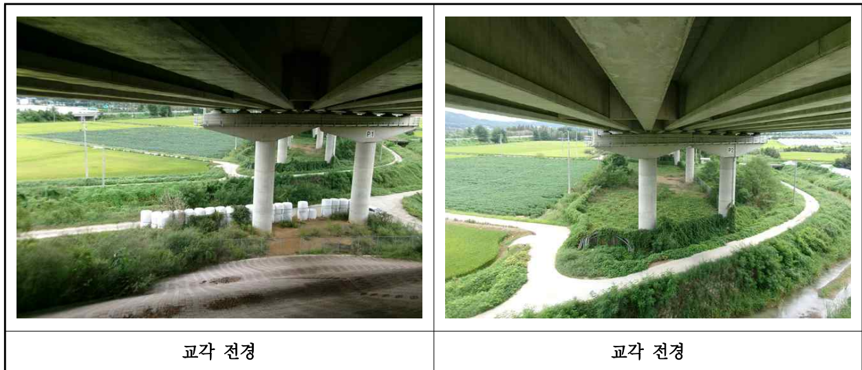
【사진 4.3.10】 교각 전경
