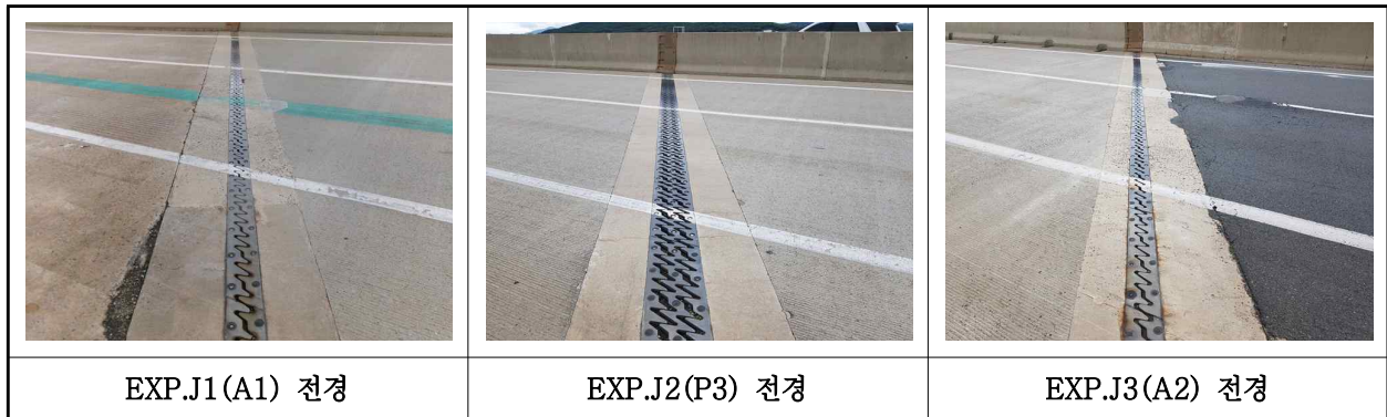
【사진 4.3.43】 신축이음장치 전경
