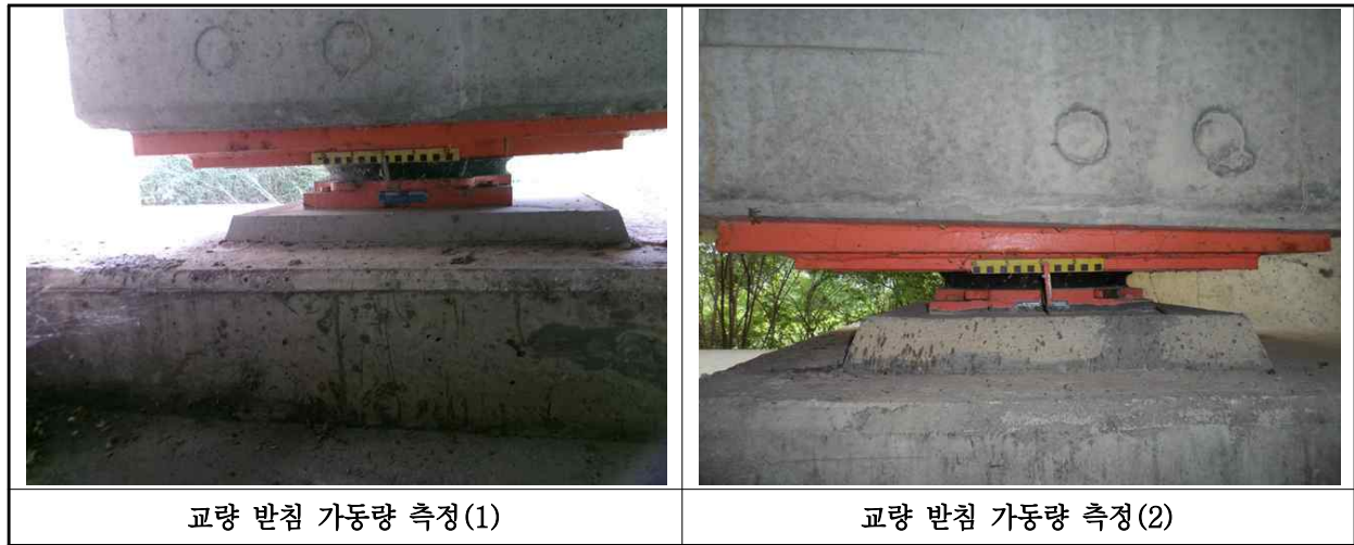
【사진 4.3.16】 교량받침 이동량 측정
