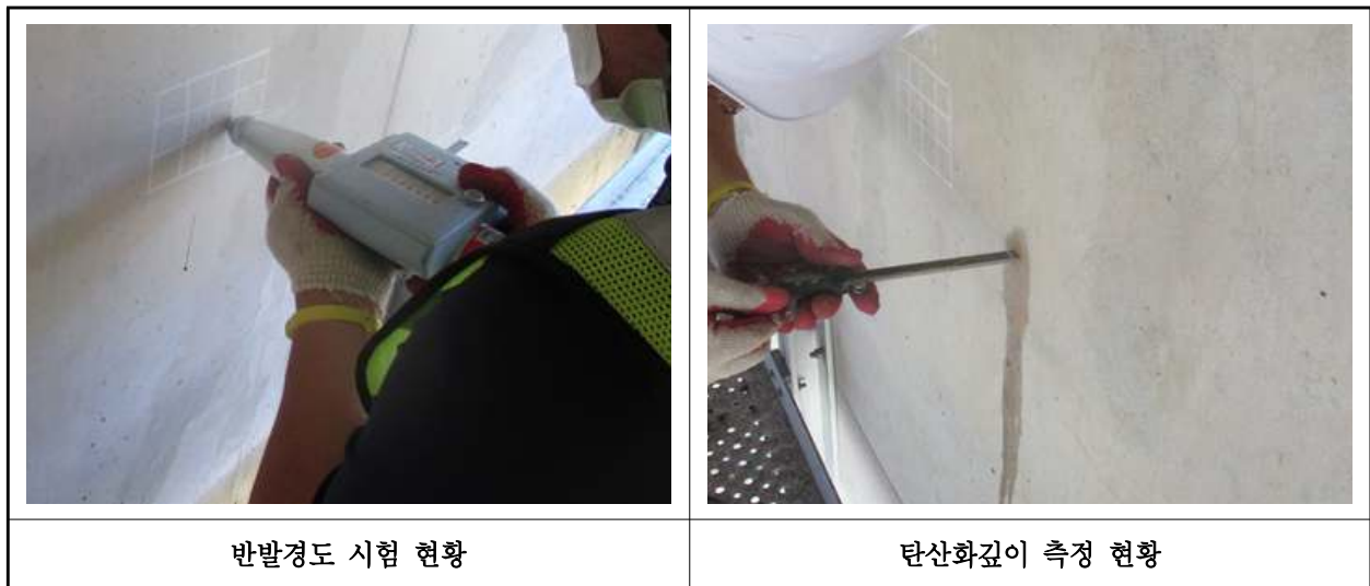
【사진 4.4.1】 콘크리트 내구성조사 현황
