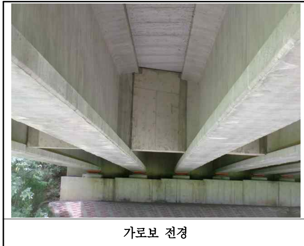
【사진 4.3.32】 가로보 전경
