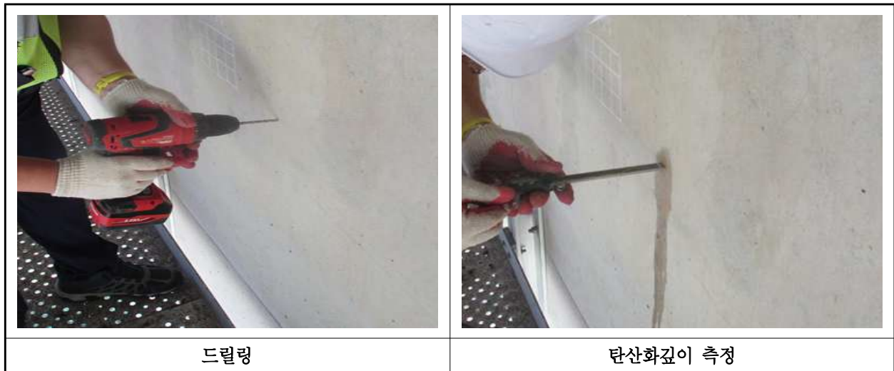
【사진 4.4.3】 탄산화 깊이 측정 현장사진
