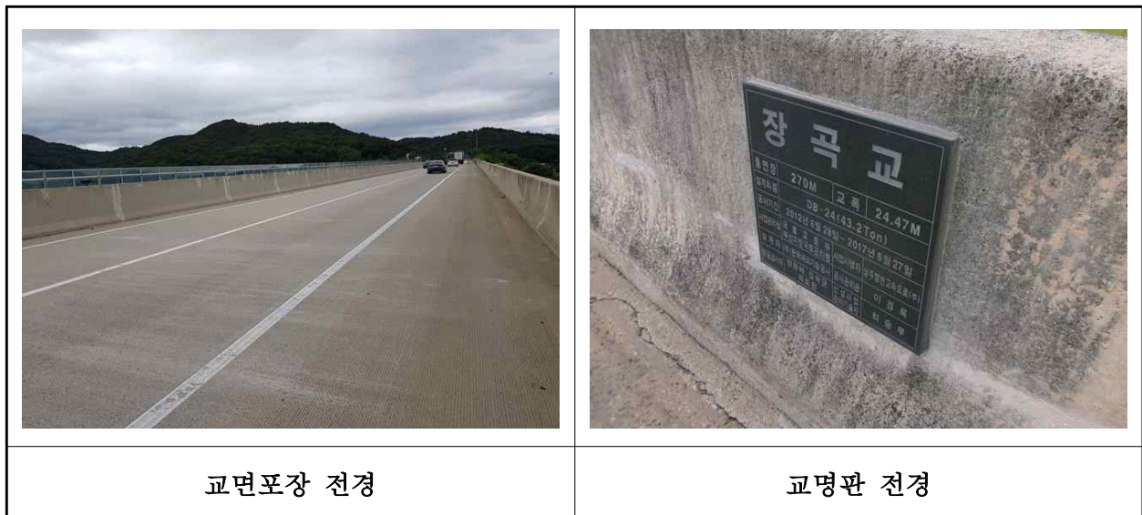
【사진 4.3.20】 교면포장 전경
