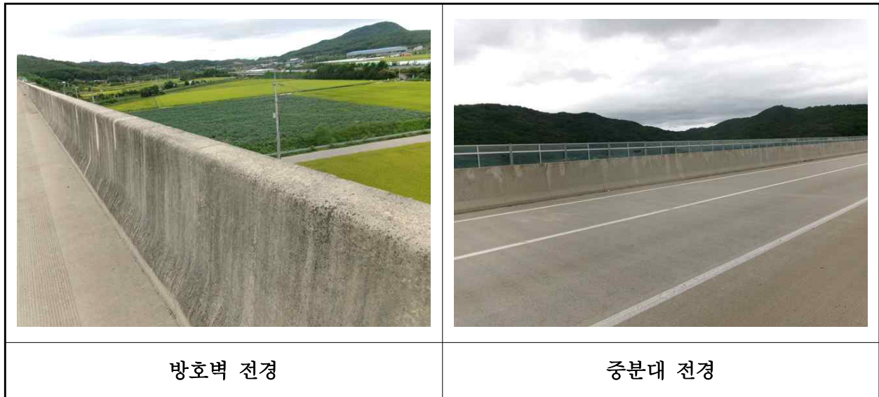
【사진 4.3.24】 방호벽 및 중앙분리대 전경
