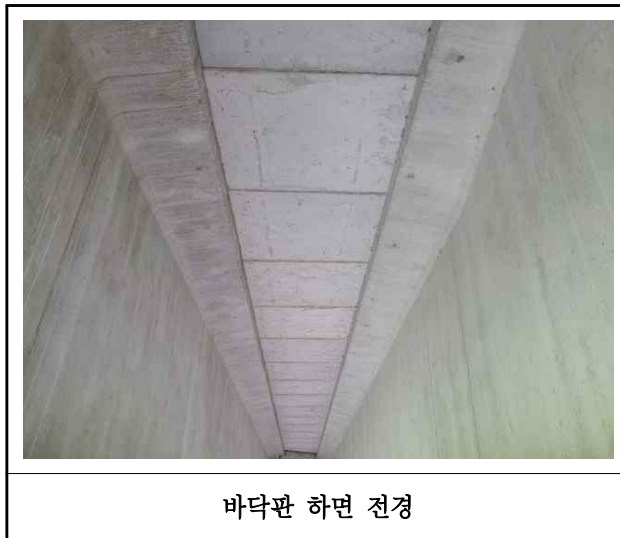
【사진 4.3.29】 바닥판하면 전경
