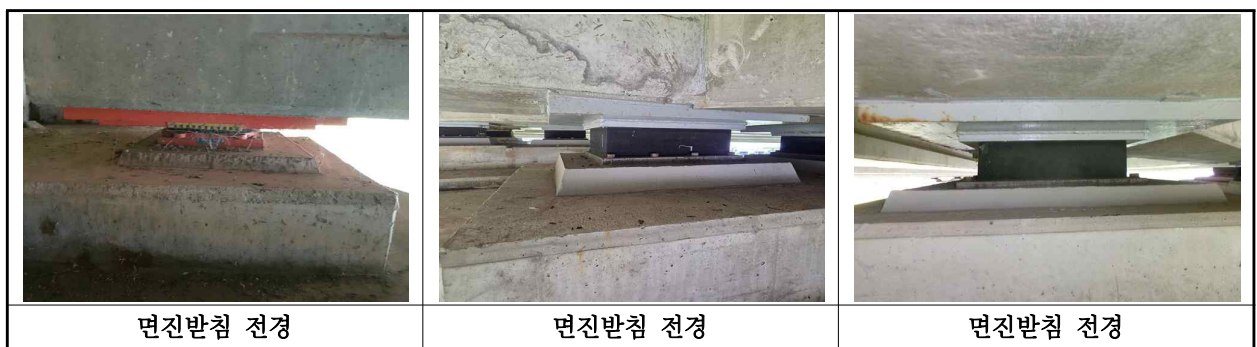
【사진 4.3.39】 교량받침 전경
