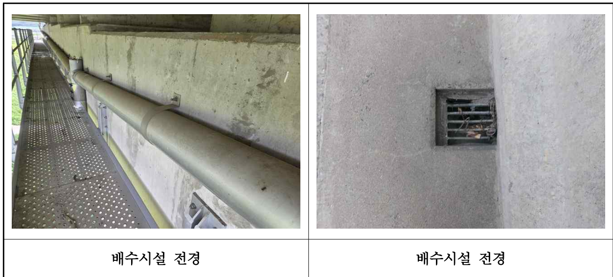
【사진 4.3.48】 배수시설 전경
