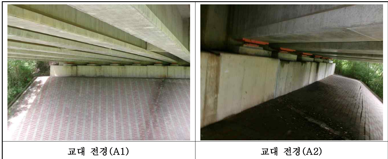
【사진 4.3.34】 교대 전경
