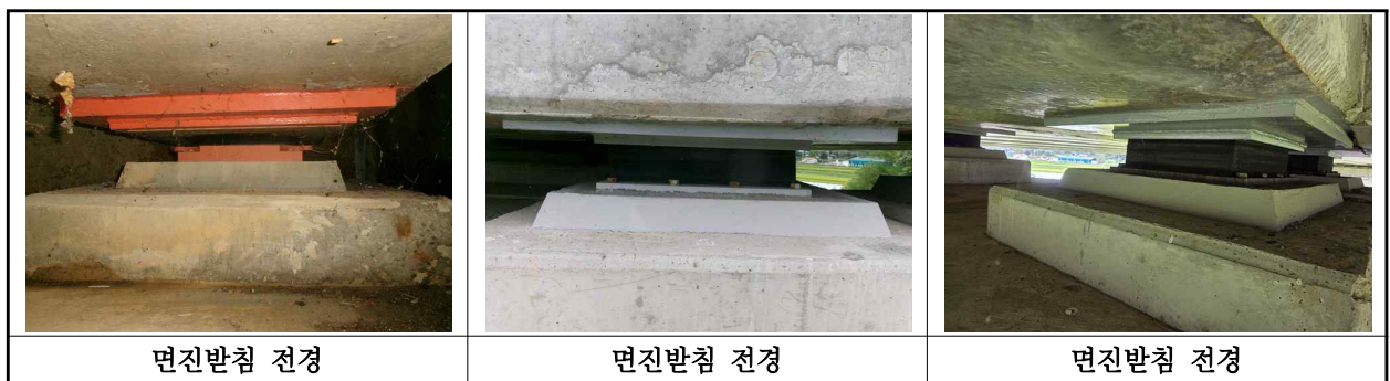
【사진 4.3.13】 교량받침 전경
