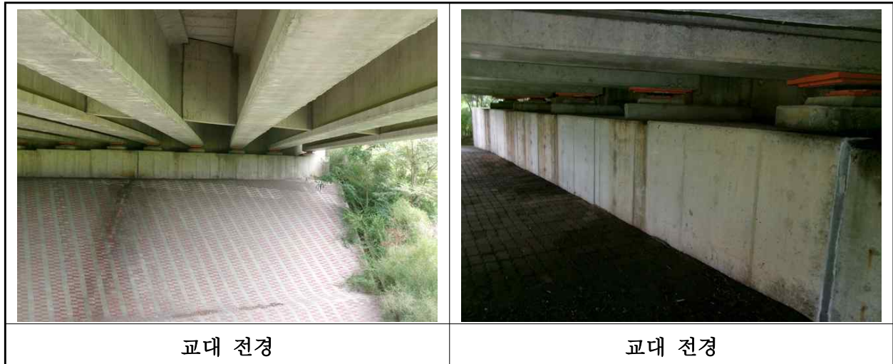
【사진 4.3.8】 교대 전경
