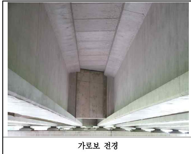
【사진 4.3.6】 가로보 전경
