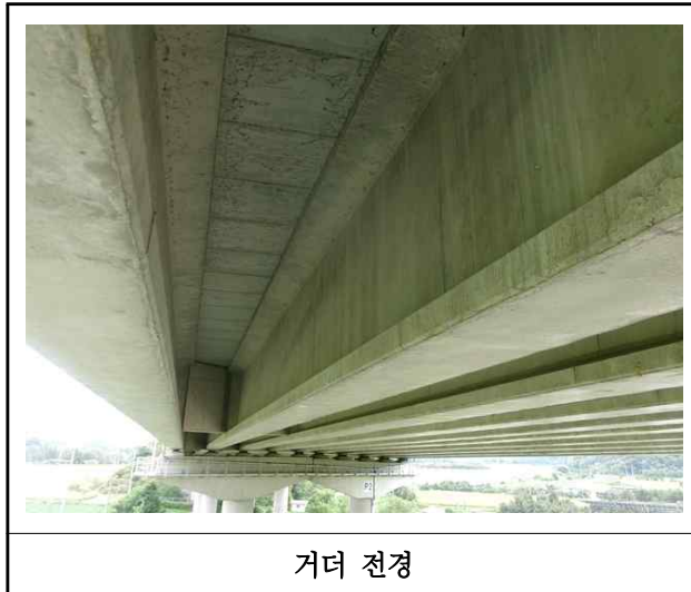
【사진 4.3.4】 거더 전경
