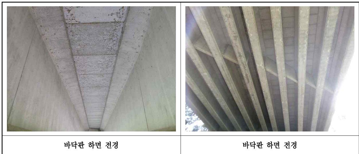
【사진 4.3.2】 바닥판하면 전경
