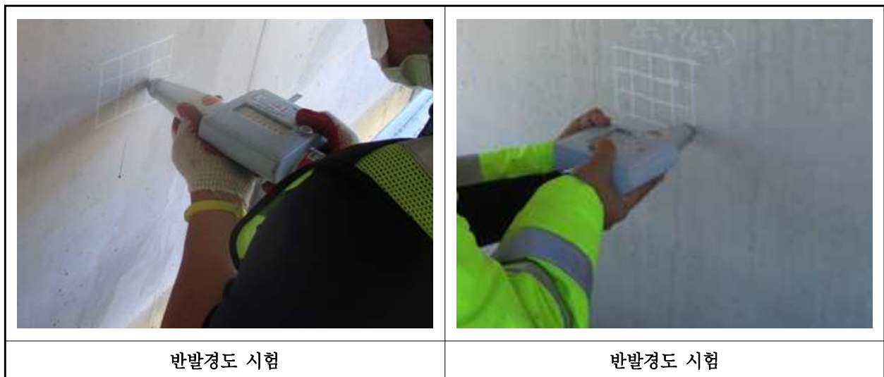
【사진 4.4.2】 반발경도시험 현장사진
