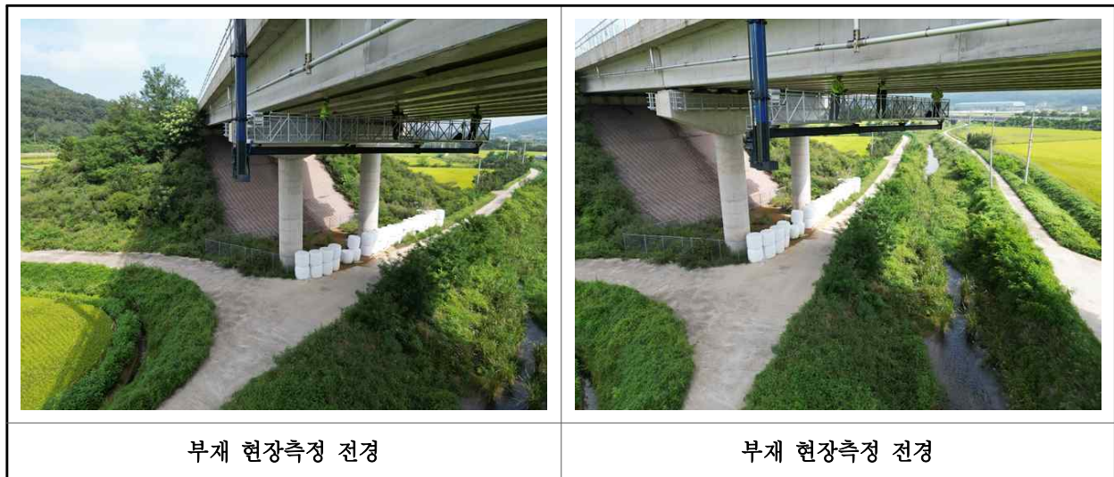
【사진 4.2.1】 부재 현장측정 전경
