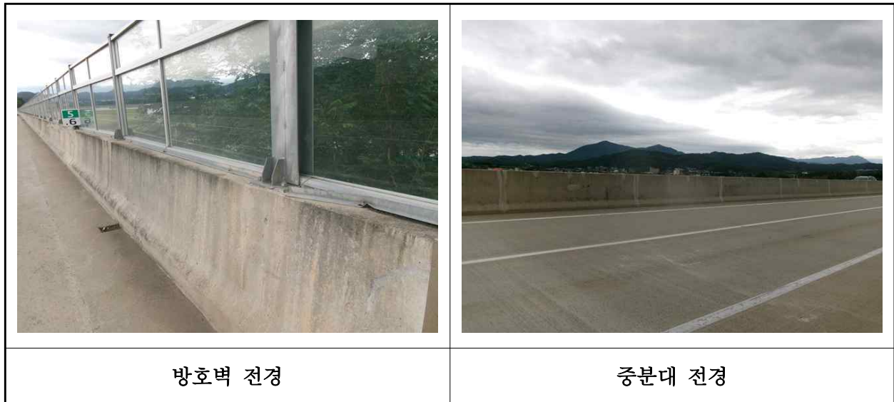
【사진 4.3.50】 방호벽 및 중앙분리대 전경
