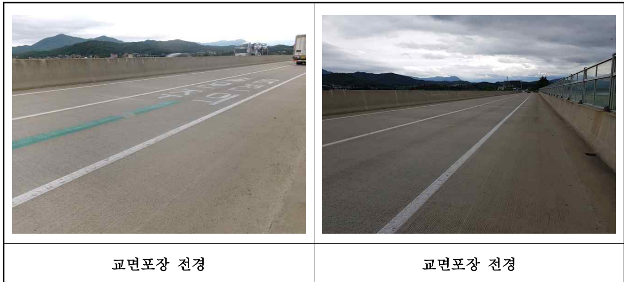
【사진 4.3.46】 교면포장 전경
