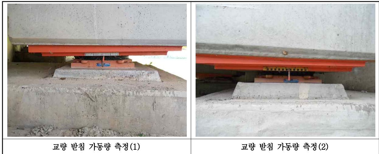
【사진 4.3.42】 교량받침 이동량 측정
